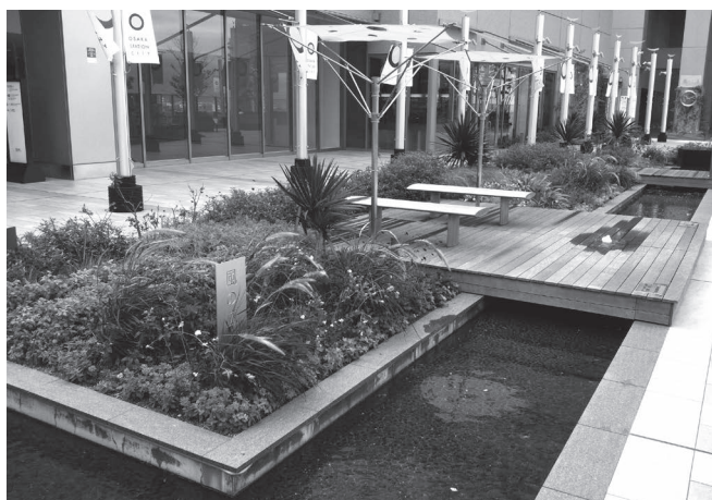
屋頂綠化 庭園灑水
